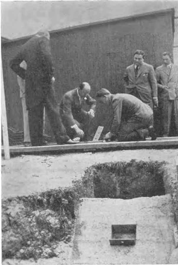
Fra Grundstensnedlæggelsen. Borgmester Jørgensen, Adolph Frederiksen og Arkitekt Arne Jacobsen. Nederst »Kassen« i Stenen til det nedmurede Dokument.
