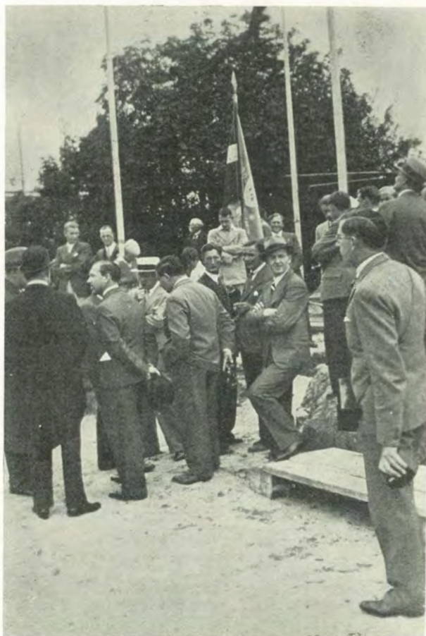
Endnu et Billede fra Grundstensnedlæggelsen. Axel Sperling, Borgmester Jørgensen, Einer Ulrich, K. E. Hoeck, Arkitekt Arne Jacobsen, Sven Mejlbo — og i Forgrunden Hans Nielsen.
