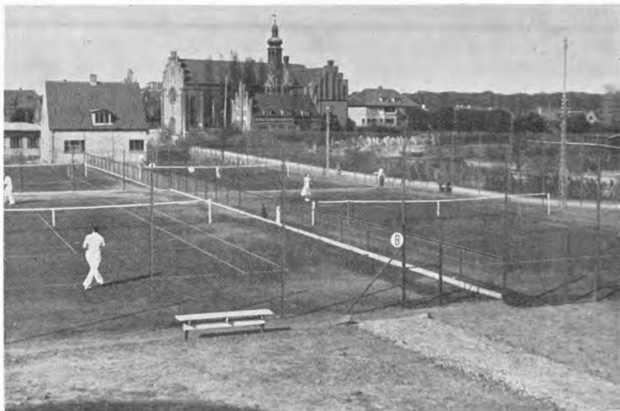
Et Hjørne af Udendørs-Anlægget paa Hartmannsvej — før det var vokset til
