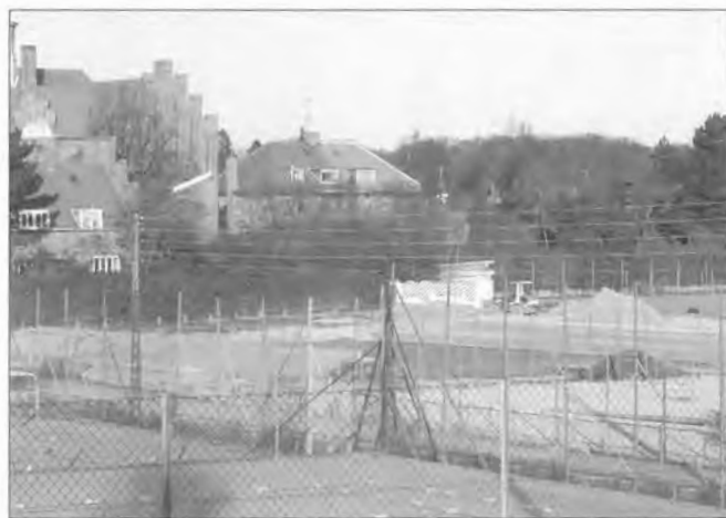
Det nye Hartmannsvej skyder op. Januar 2001
